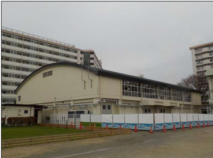
No.2 調布市立国領小学校体育館改修工事 体育館外部 施工状況
