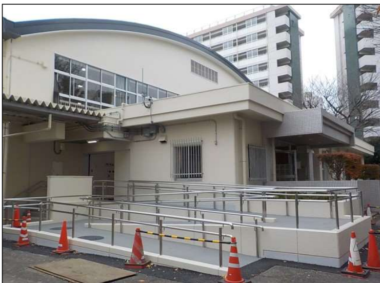
No.3 調布市立国領小学校体育館改修工事 スロープ設置 施工状況
