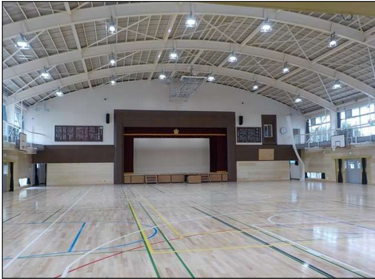
No.4 調布市立国領小学校体育館改修工事 体育館内部 施工状況
