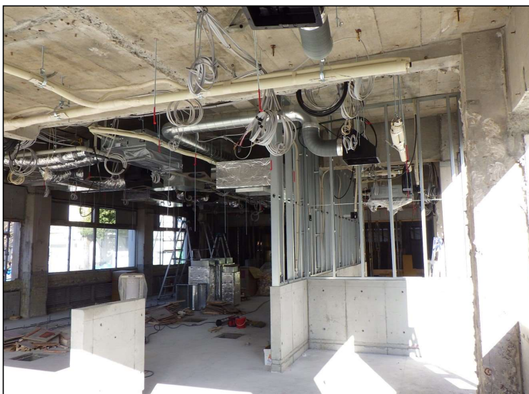
No.6 調布市立柏野小学校給食室改修工事 給食室内部 施工状況
