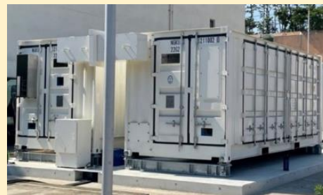
大型蓄電池再構築
