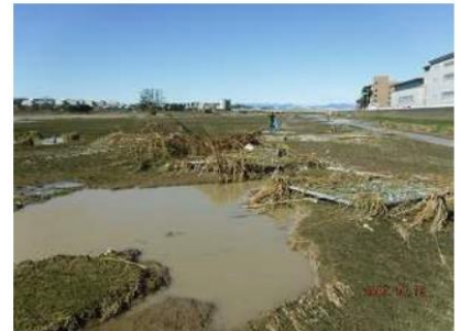
令和元年台風19号の影響により大きな被害を受けた多摩川児童公園内のグラウンド
