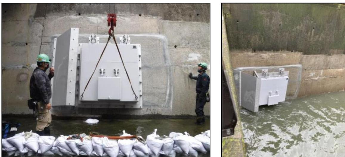
図 3-2-4 逆流防止ゲート設置状況
