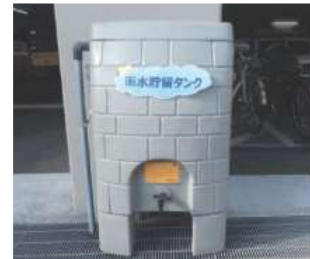
雨水貯留タンク
