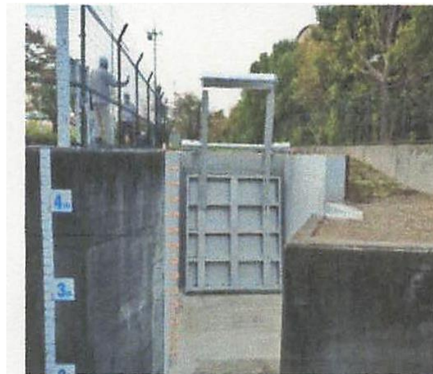
根川第1雨水幹線への逆流防止ゲートの設置
