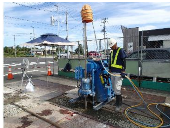
地盤改良状況
