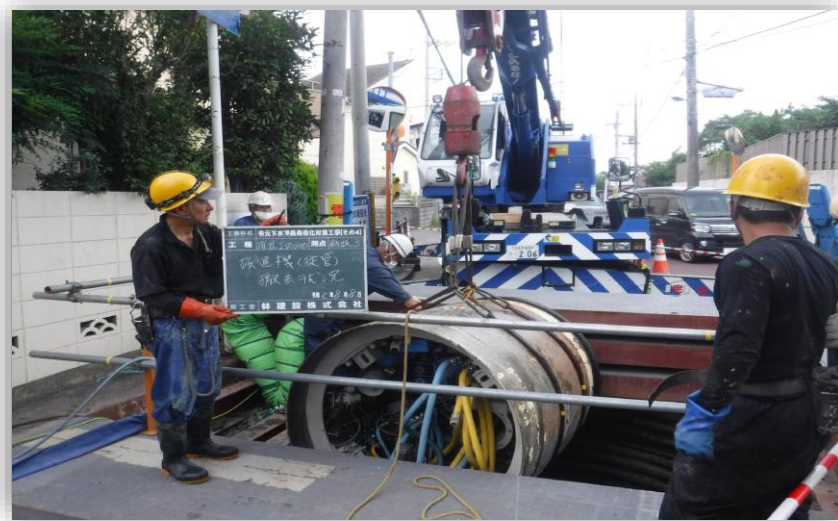
到達立坑からミニシールドを撤去する様子
