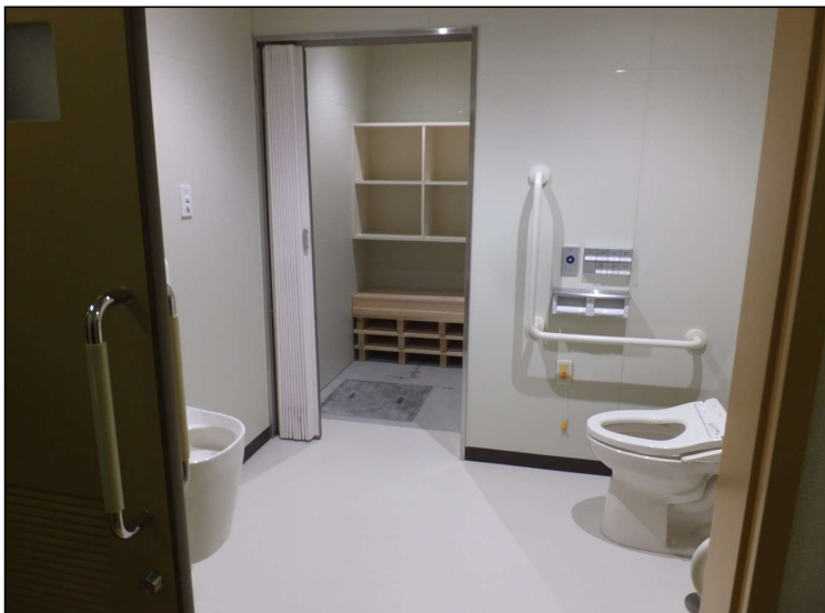
No.9 調布市八ヶ岳少年自然の家機械設備改修工事
