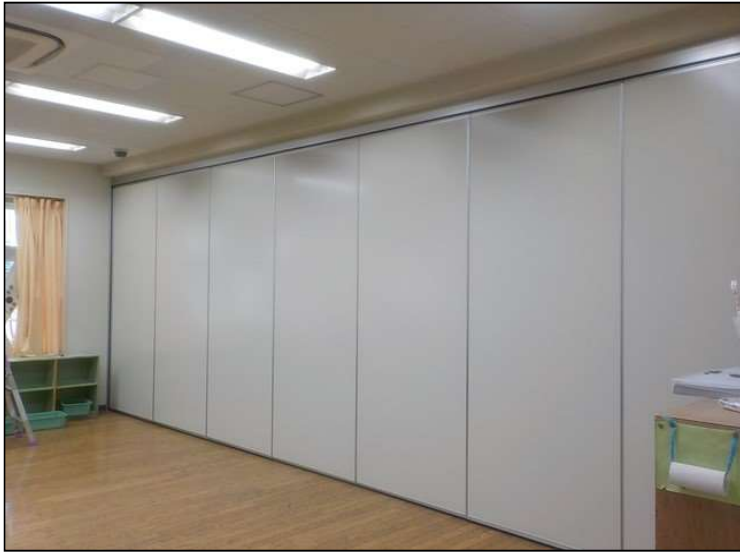
No.7 調布市立滝坂小学校特別支援学級 スライディングウォール設置工事
