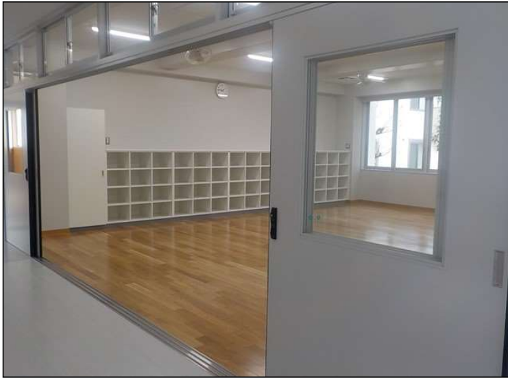
No.1 調布市立多摩川小学校校舎増築工事
