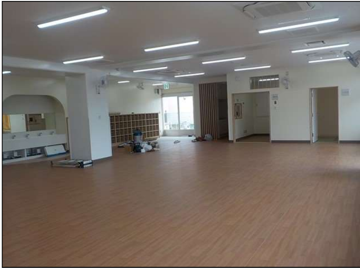
No.4 調布市立布田小学校校舎増築工事
