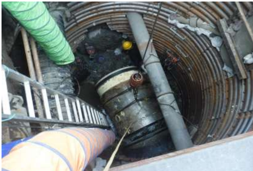
真上から見た立坑内の様子
