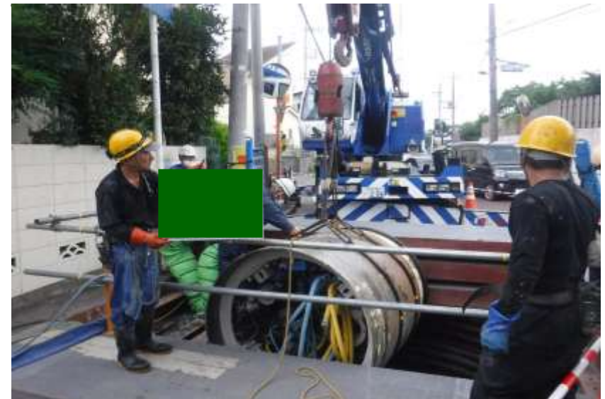
到達立坑から推進機を撤去する様子
