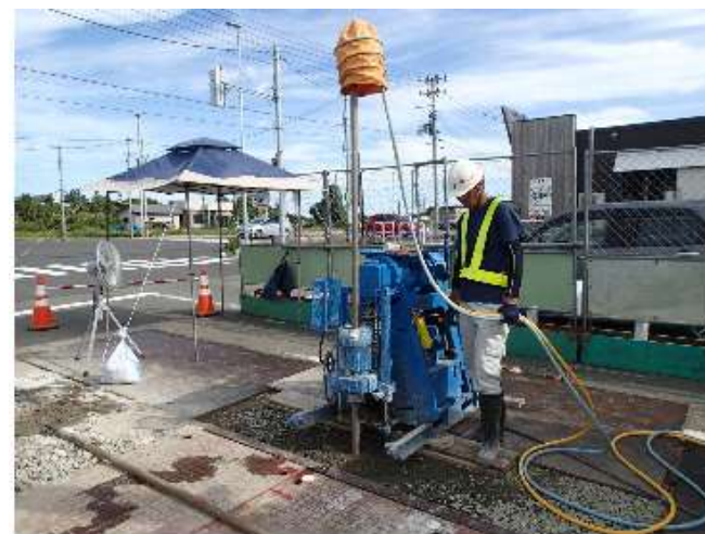
地盤改良状況
