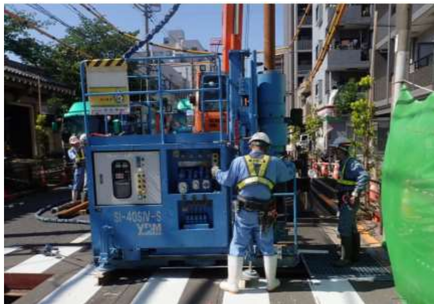
高圧噴射攪拌工事のイメージ写真
