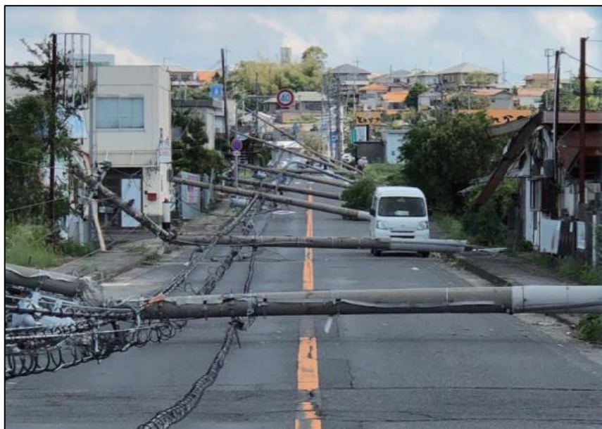
平成30年台風第21号による電柱倒壊(大阪府泉南市) 出典:国土交通省
