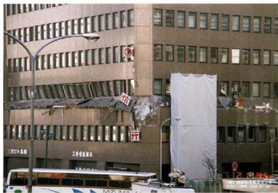
(d) ビルの損壊
