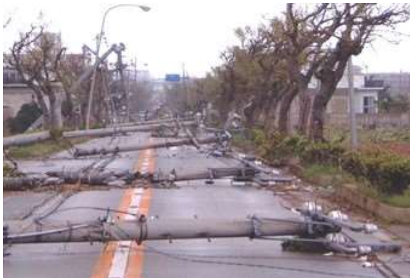
図 4-3 台風で電柱が倒壊し災害時の救援活動の妨げとなったケース（沖縄県）
