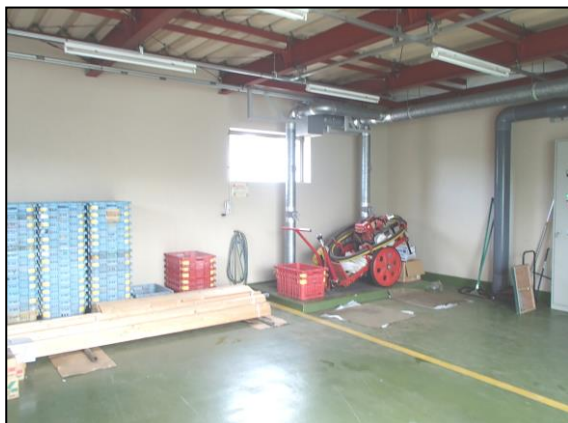
③ し尿投入口
