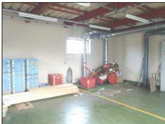
③ し尿投入口
