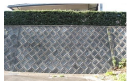
間知ブロック積擁壁
