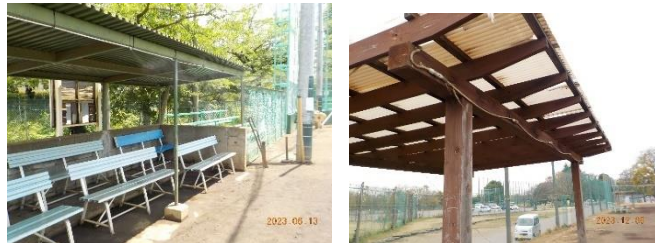
スポーツ施設におけるミストシャワーの設置 (左：市民野球場，右：調布基地跡地運動広場)
