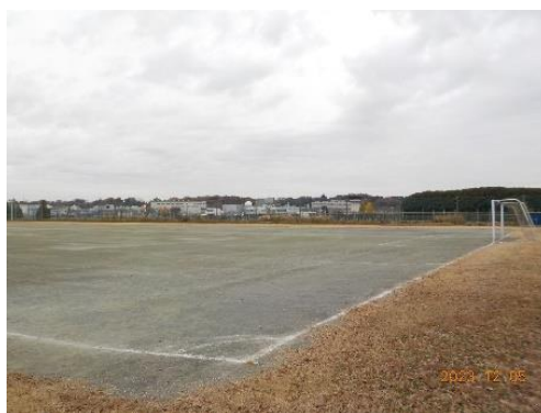
グリーンダスト舗装をしたグラウンド（調布基地跡地運動広場）
